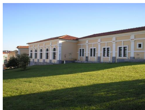
Figura 127 – Sede da União de Freguesias de Arcos e Mogofores (Centro Cultural Vale Santo, Anadia)
