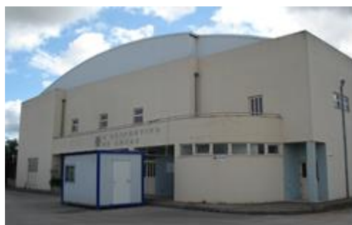
Figura 69 – Pavilhão Desportivo de Ancas
