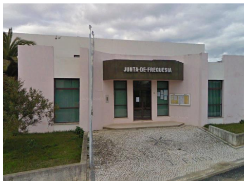
Figura 132 – Junta de Freguesia de Avelãs de Caminho
