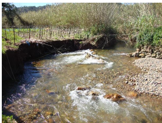
Figura 23 – Rotura de margem do Rio da Serra, danificando parte de uma vinha, em Vila Nova de Monsarros
