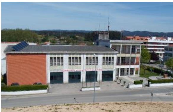
Figura 11 – Fachada do Quartel dos Bombeiros Atual (Fonte - cagido.blogs.sapo.pt )
