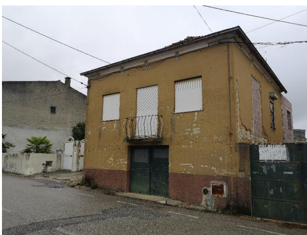
Figura 37. Fachada com fissuras
