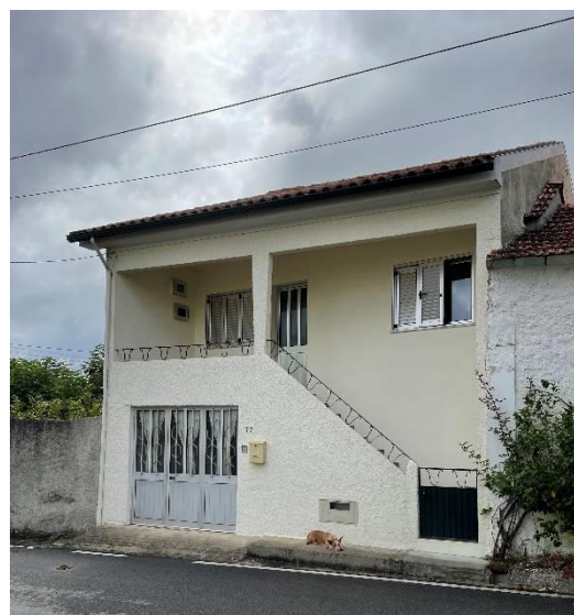
Figura 33. Cobertura com beirado e caleira
