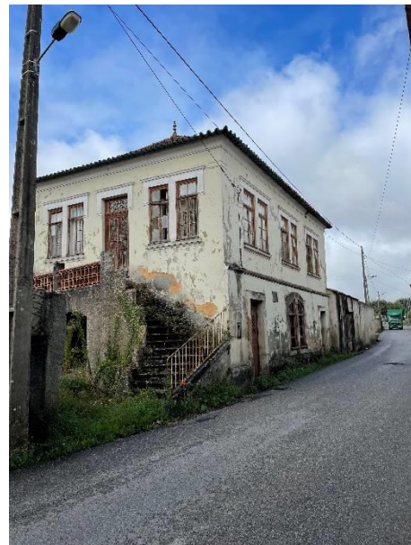
Figura 38. Desagregação do reboco
