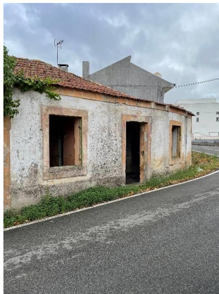
Figura 41. Edifício sem caixilharia
