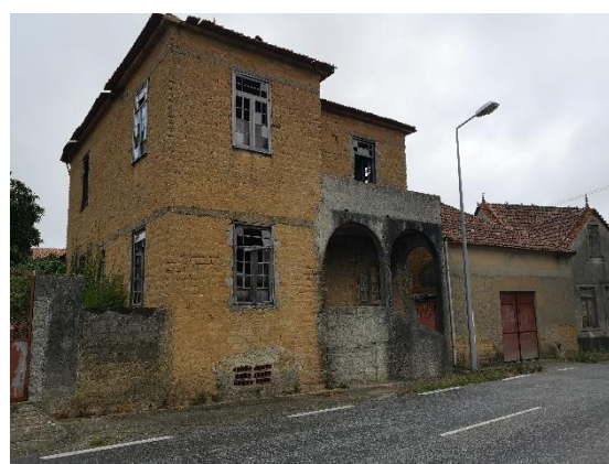
Figura 40. Caixilharias degradadas
